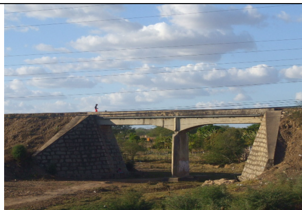
Ilustração 26 – Ponte sobre o leito seco de um riacho, nas proximidades da sede do município. Soledade-PB. Pesquisa direta, outubro de 2007. Foto do autor.
