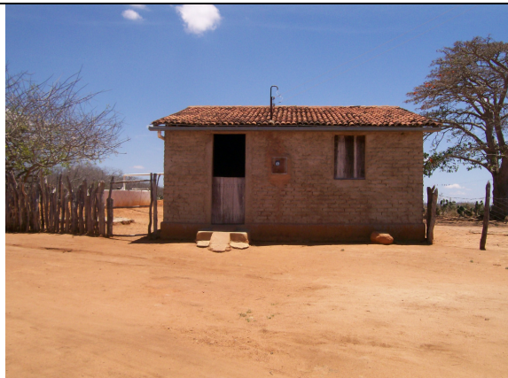
Ilustração 33 – Cisterna de placa reduziu a distância dos locais de acesso à água. Lajedo de Timbaúba. Soledade-PB Pesquisa direta, outubro de 2007. Foto do autor.
