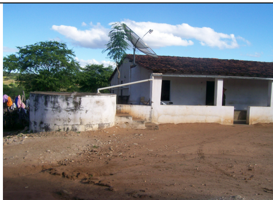
Ilustração 31 – Cisterna de placa destinada ao consumo humano através da captação da água da chuva. Lajedo de Timbaúba. Soledade-PB Pesquisa direta, outubro de 2007. Foto do autor.
