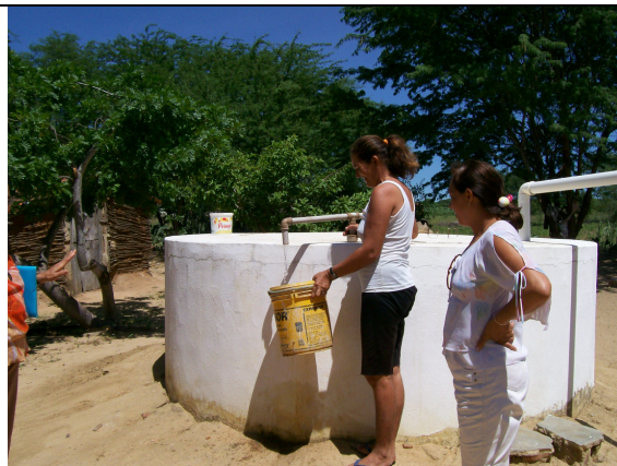
Ilustração 36 – Retirada da água da cisterna através da bomba de bola de gude, feita artesanalmente pelos camponeses, mediante transferência de conhecimento da ASA. Cajazeiras II. Assunção-PB. Pesquisa direta, junho de 2007. Foto do autor.
